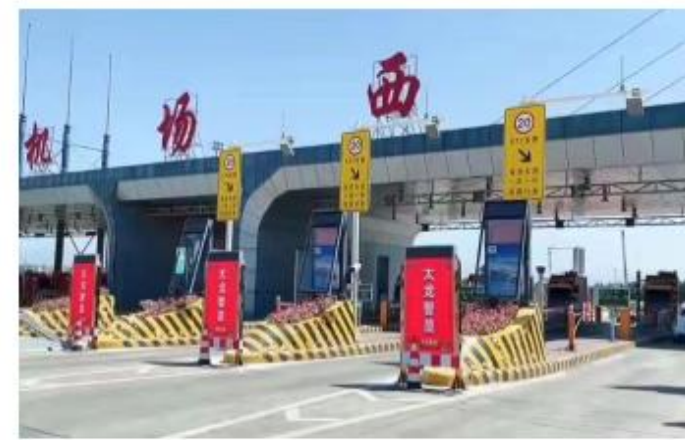
西安绕城高速机场西收费站
